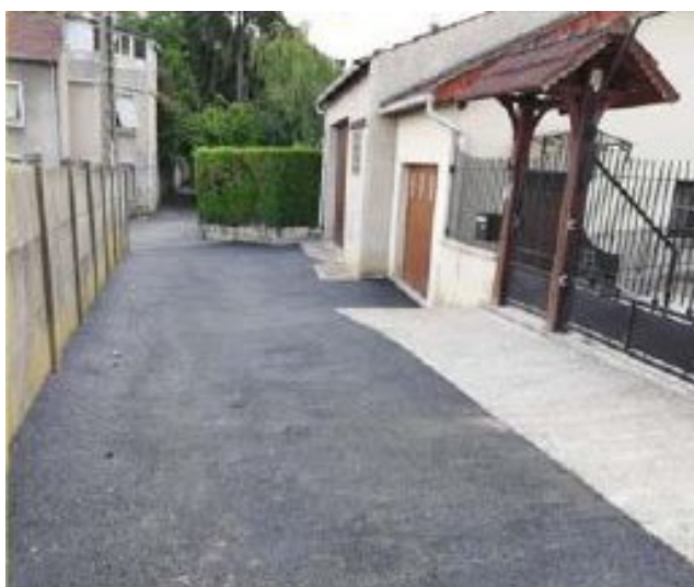
Sentier Challoy après les travaux
