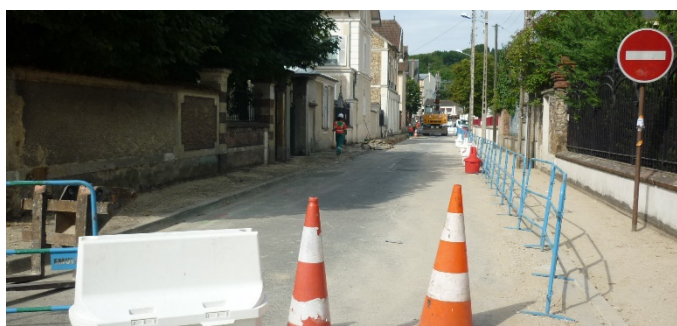
Rue Estienne d'Orves pendant les travaux
