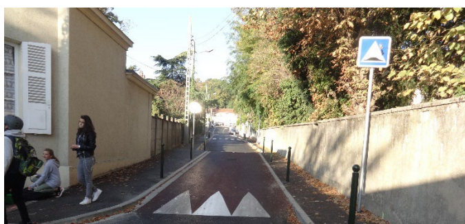
Rue Estienne d'Orves après les travaux
