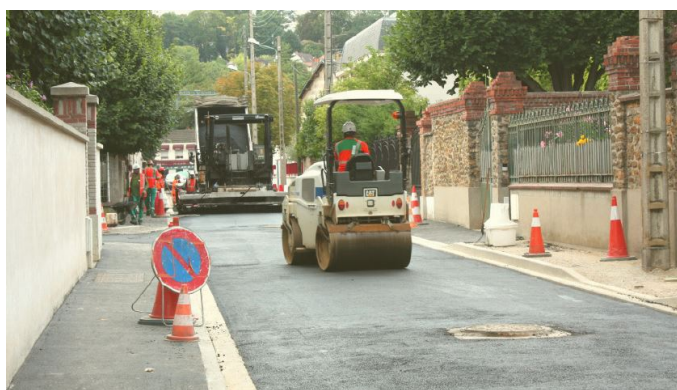
Rue du Maréchal Foch pendant les travaux
