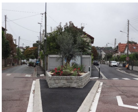
Jardinière rue Pitois après travaux
